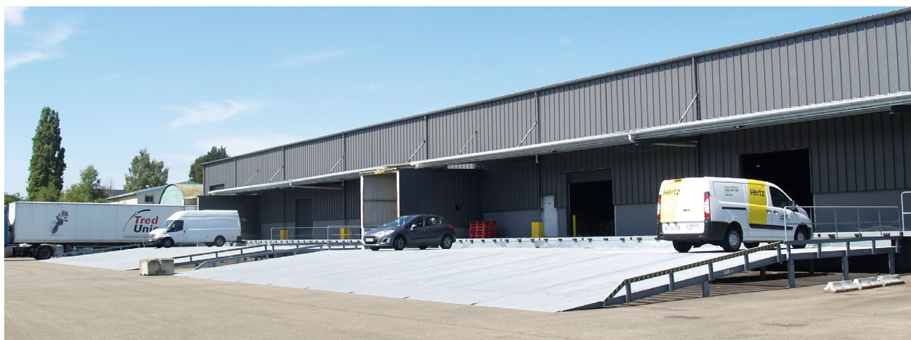
Rampe fixe, longueur 20 mètres sur 35 mètres de bâtiment servant au déchargement des camionnettes
