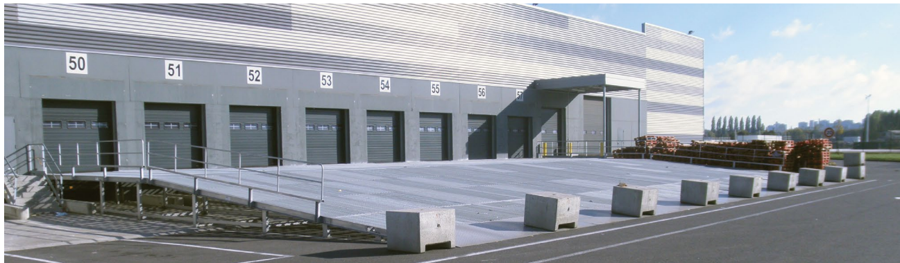
Rampe fixe, longueur 20 mètres sur 35 mètres de bâtiment servant au déchargement des camionnettes
